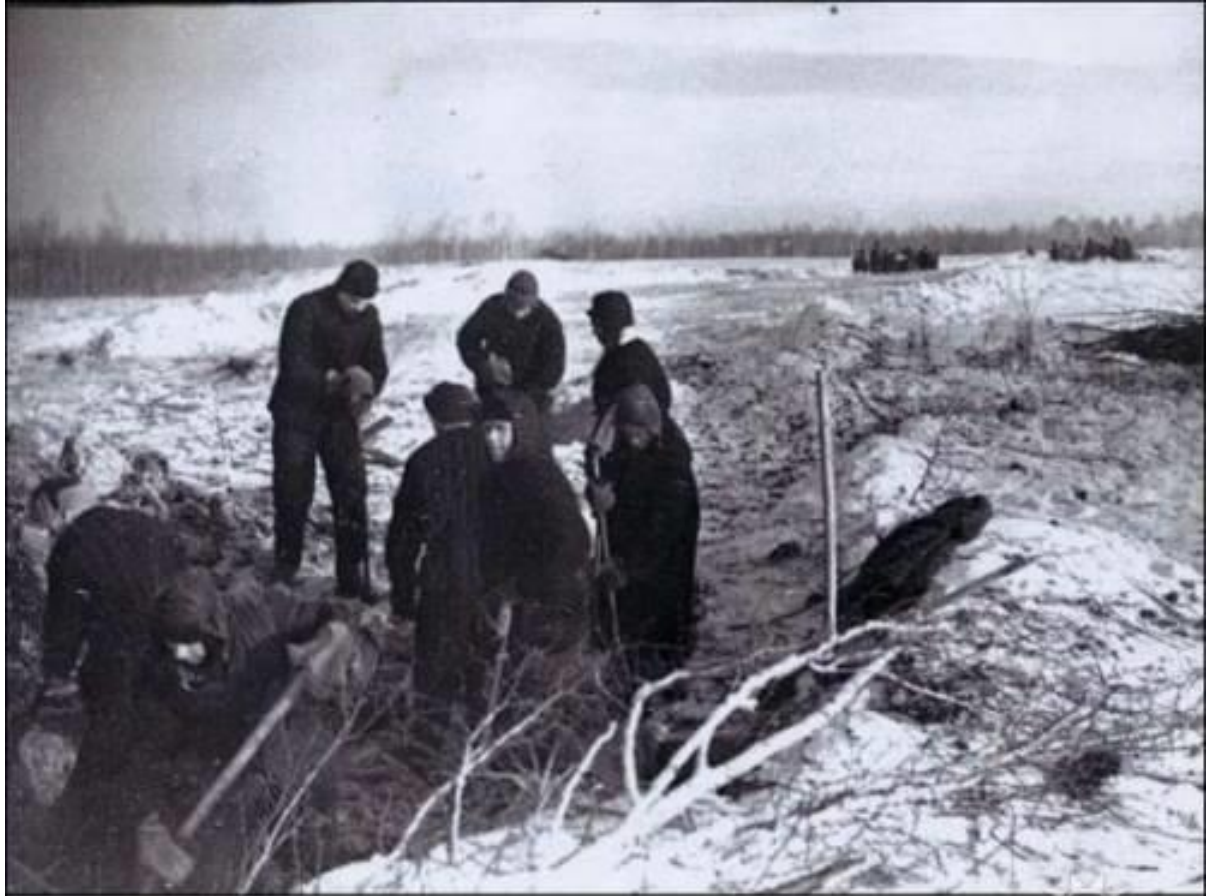
Erste deutsche Zwangarbeiter bei der Ankunft auf die Baustelle Tscheljabmetallurgosroj des NKWD, Frühling 1942.
