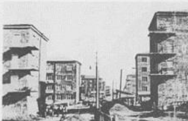
Рис. 30. Магнитогорск. Строительство первого квартала соцгорода (ул. Пионерская). Фото начала 1930-х гг. Источник: Архив МУ «Магнитогорский краеведческий музей»
