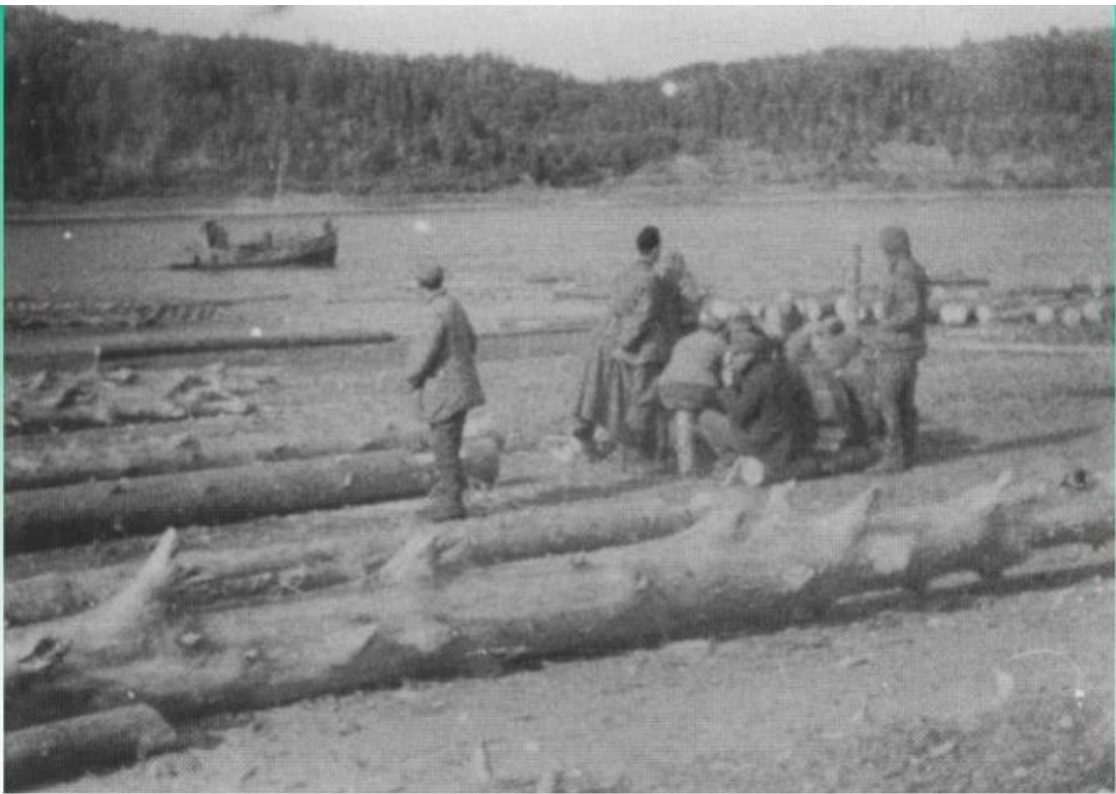
27 Jelabuga-Kosyltau, Sept. oder Okt. 1945 Floßbauplatz am Ufer der Kama. Die Brigade sitzt am Feuer, um sich in einer Arbeitspause zu wärmen. Das kleine Motorboot diente dem Bugsieren der Stämme bzw. Flöße. Bei dieser Arbeit ist es häufig zu tödlichen Unfällen gekommen.
